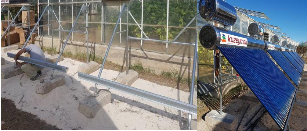
Şekil 2. Vakum borulu toplaçlarından oluşan ısı toplama ünitesi
